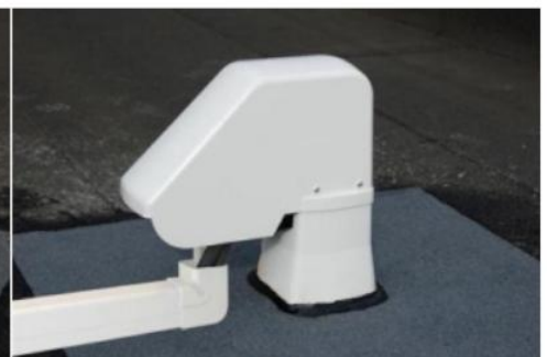
Gebruik goot om het leidingwerk te beschermen op het dak
