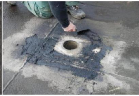
Bestrijk het gebied rond het gat met bitumen afdichtmiddel
