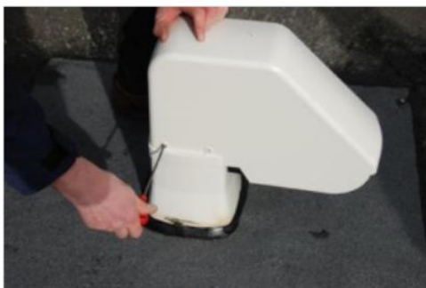
Dicht de randen van de dakbedekking af in de richting van de dakopening met bitumenafdichting
