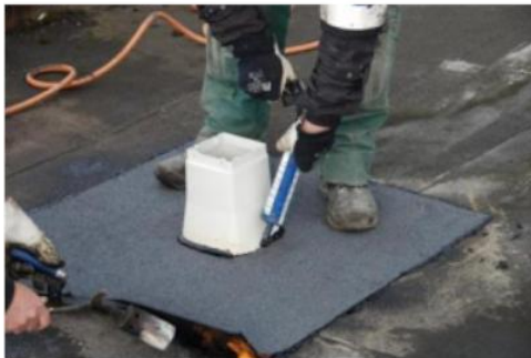
Dicht de randen van de dakbedekking af in de richting van de dakopening met bitumenafdichting
