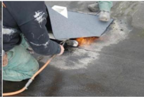
Snij een bitumen dakbedekking blad en plaats over de voet van de dakdoorvoer
