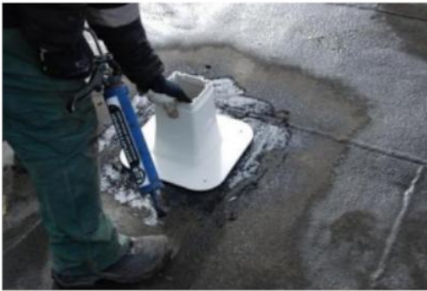
Plaats de dakdoorvoer over het gat en druk aan
