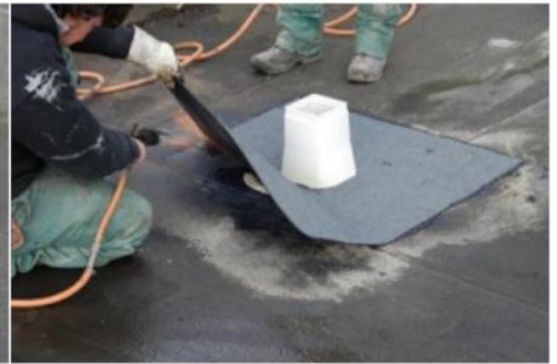
Bestrijk de onderkant van de doorvoer met bitumen afdichtmiddel
