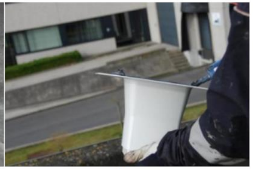
Bestrijk de onderkant van de doorvoer met bitumen afdichtmiddel
