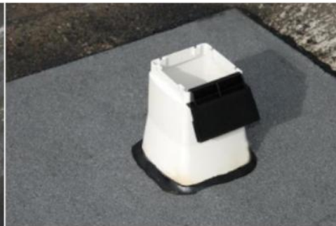
Snij een bitumen dakbedekking blad en plaats over de voet van de dakdoorvoer
