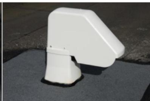
Gebruik de schroeven om de kap te bevestigen aan de voet van de doorvoer
